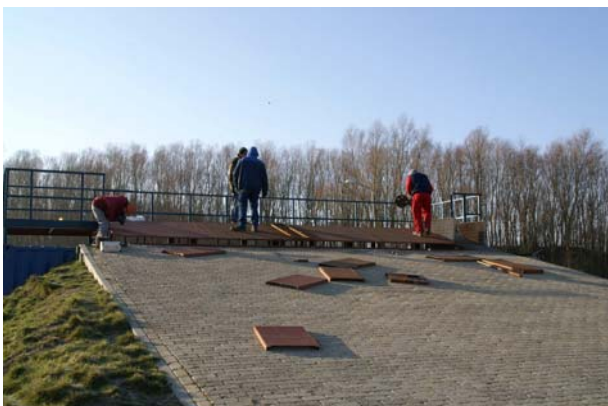
De metalen platen worden losgehaald
