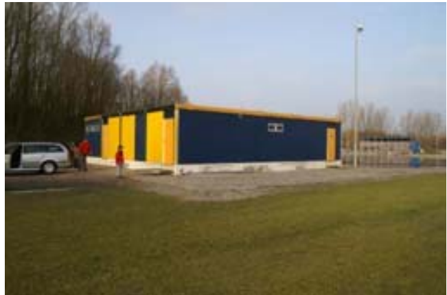
Het terras voor het clubgebouw
