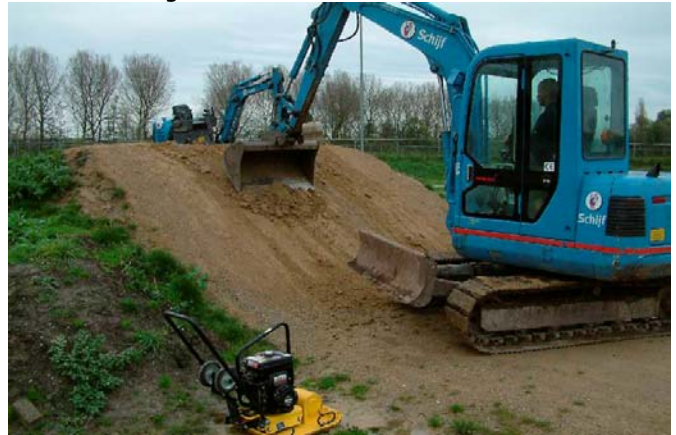
Bestaande lagen worden verwijderd
